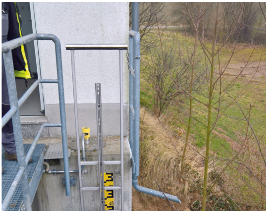
Der Aufstieg zum Hochwasserrückhaltebecken vor dem Einbau der Rettungsanlage.
