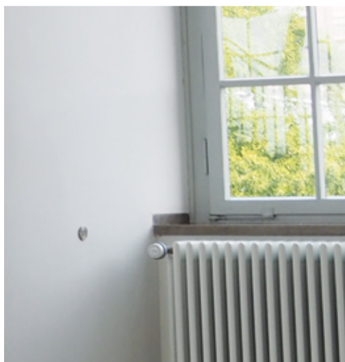
Unauffällig in Edelstahl, die verbaute Einsteckhülse.
